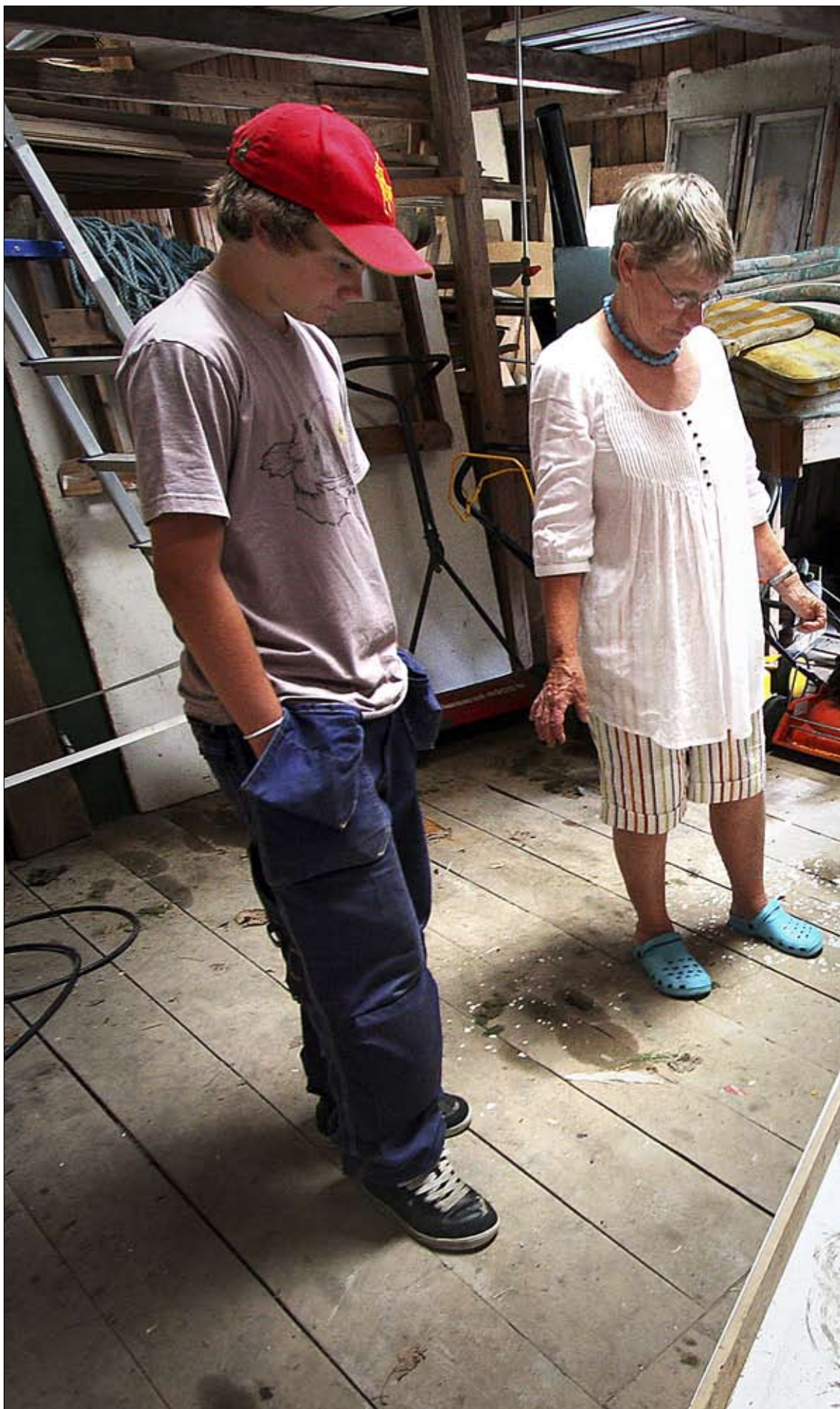
Barnbarnet Viktor Eriksson har snickrat ramen till det som ska bli en "dörrmatta" i betong. Dörrmattan av
